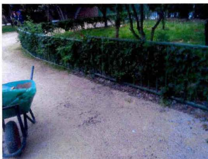
Fotografía N° 8: Borde de estacionamiento sin rollizos desde acceso.
