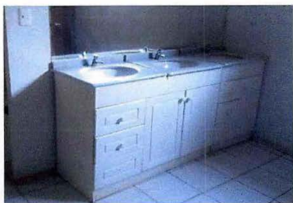
Fotografía N° 3: 3 lavamanos en baño varones.
