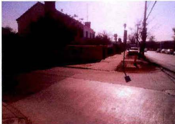
Fotografía N° 12: Calles Arcadia y San Ignacio de Loyola, esquina poniente, sin obras de reducción de velocidad.
